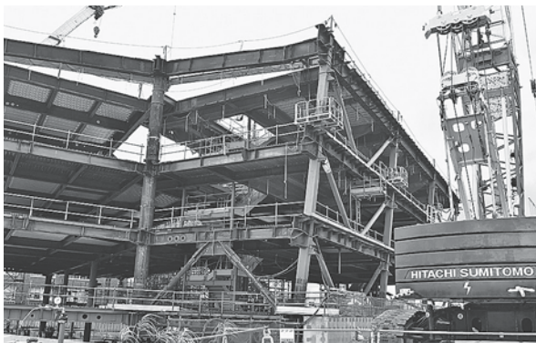
建設中の市役所本庁舎（令和3年）
