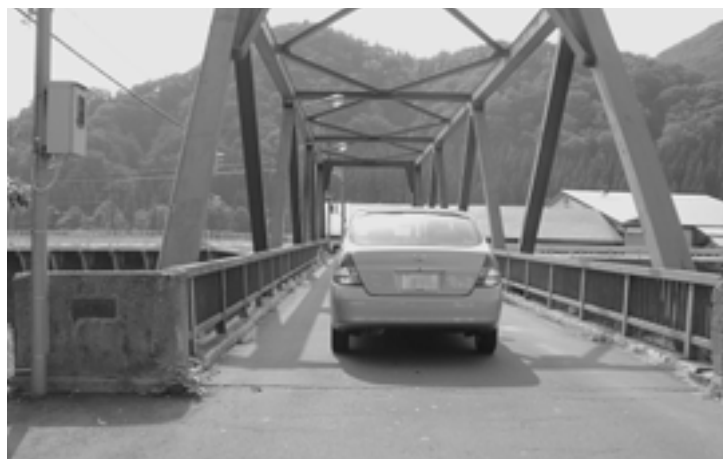
今年度、市道調査の予定だった古懸の不動橋
