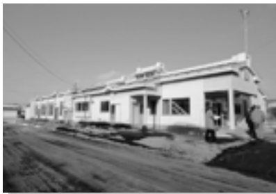
金屋地区多目的研修施設
